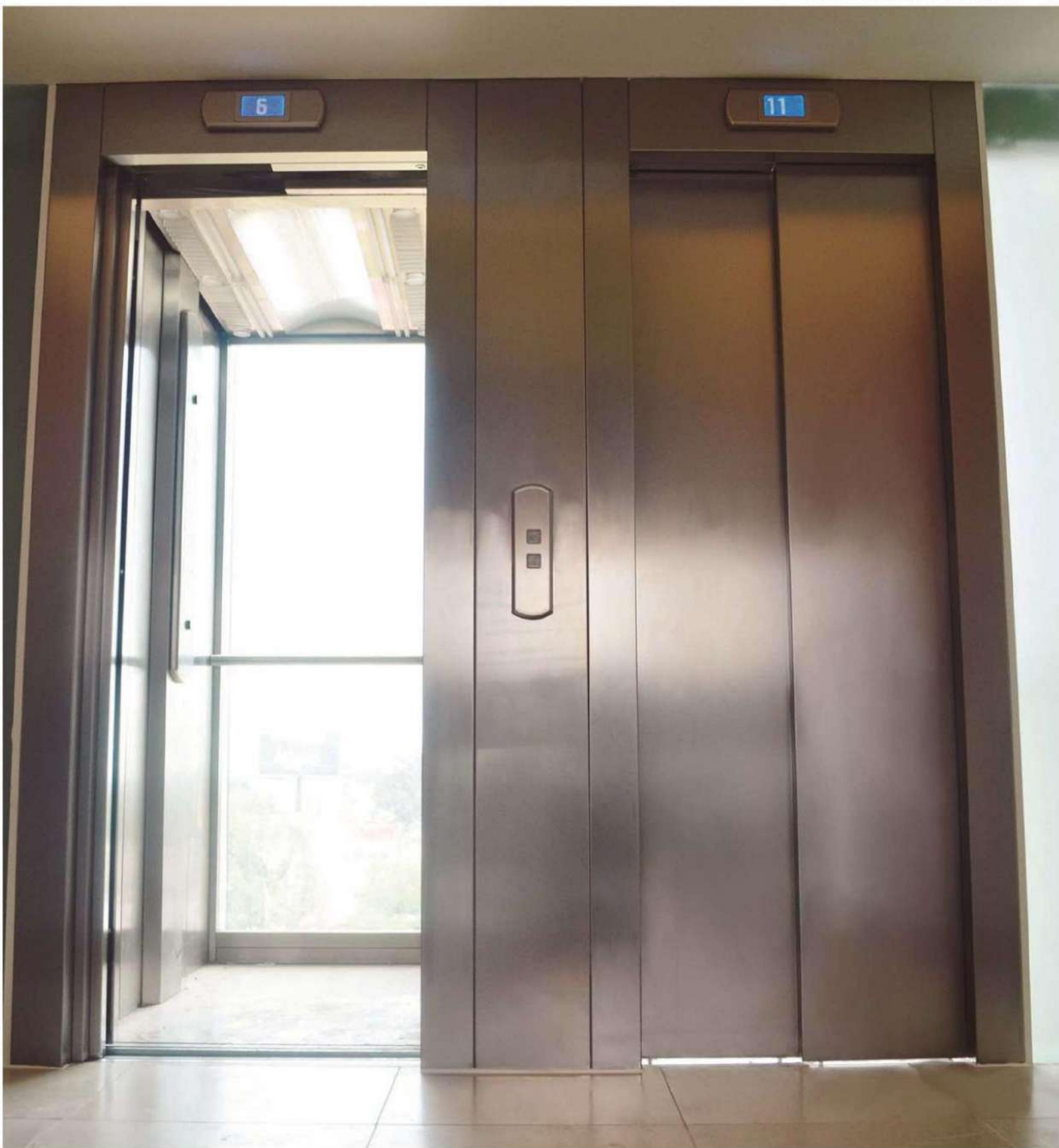
PUERTAS AUTOMATICAS DE APERTURA TELESCOPICA, ACABADOS EN ACERO INOXIDABLE
